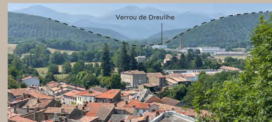
Le bassin versant du Touyre depuis Laroque d'Olmes avec son patrimoine industriel et le « verrou » du Plantaurel, porte d'entrée naturelle du Pays d'Olmes.
