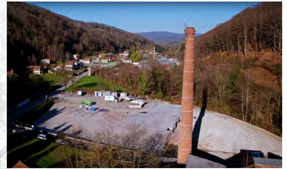
Les anciennes cheminées de usines deviennent des témoins de l'histoire du territoire
