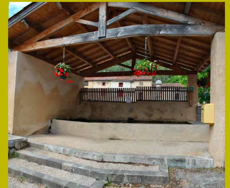
Exemple de rénovation du lavoir sur la commune de Roquefixade
