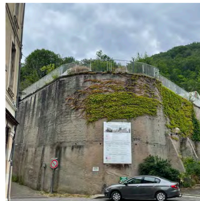
⑦ C'est le terrain d'un ancien EHPAD qui a été démolì. La mairie de Lavelanet a un projet d'implantation d'agrès et de parcours sportif sur cet espace en balcon sur la ville.
