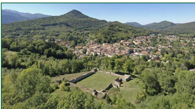
Restauration bénévole du château d'Amont par les habitants de Bélesta.
