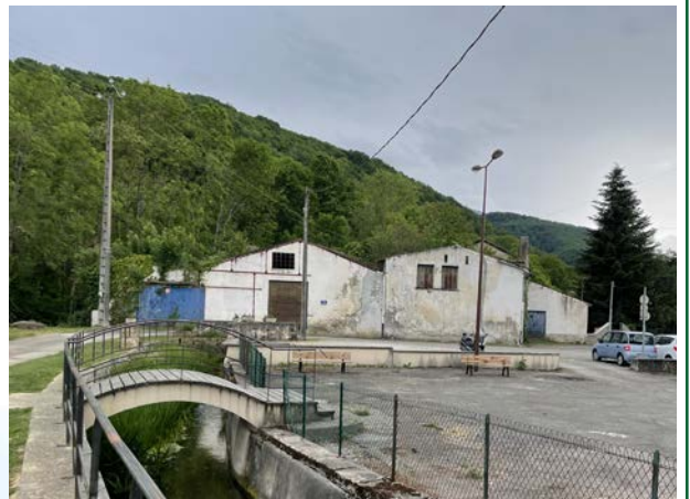
Photographie de la friche abandonnée de Villeneuve-d'Olmes
