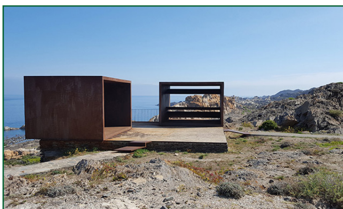
Photographies du projet de déconstruction du Club Med dans le Cap de Creus. Projet réalisé par le paysagiste Marti Franch et son équipe.
