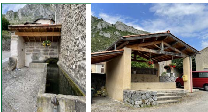
Rénovation des anciens lavoirs et abreuvoirs sur la commune de Roquefixade
